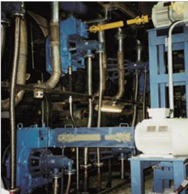
Trockenzylinderantrieb mit FLENDER-Stirnrad-Aufsteckgetriebe der Bauart SHZP 300 Drying cylinder drive with shaft-mounted FLENDER helical gear units of type SHZP 300 Entraînement du cylindre sècheur avec réducteur cylindrique à arbre creux du type SHZP 300
